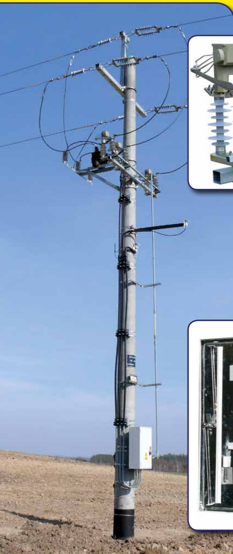
Rozłącznik napowietrzny z komorami próżniowymi, typ SRNkp-24/400
