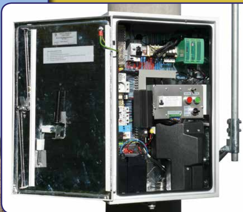
Napęd silnikowy ze sterownikiem GSM/GPRS, typ NKM-1.3
