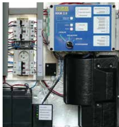
Fot. 1. Napęd rozłącznika z zastosowaniem superkondensatorów i akumulatorów.
